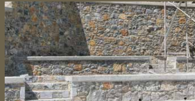
Τοίχος αντιστήριξης στους Πύργους Περάματος
