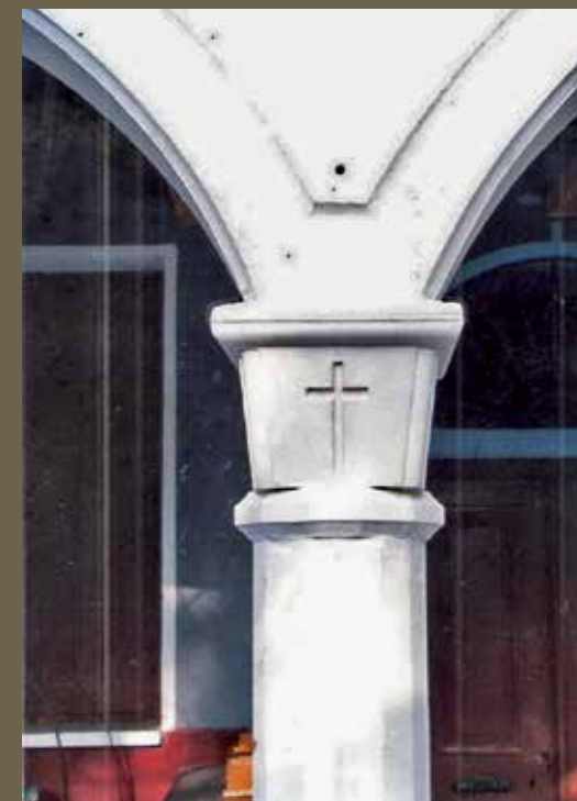
Εκκλησία στην Ευρειακή (νάρθηκας από εμφανές σκυρόδεμα)
