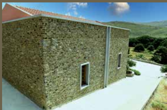
Υδροροές από εμφανές σκυρόδεμα
