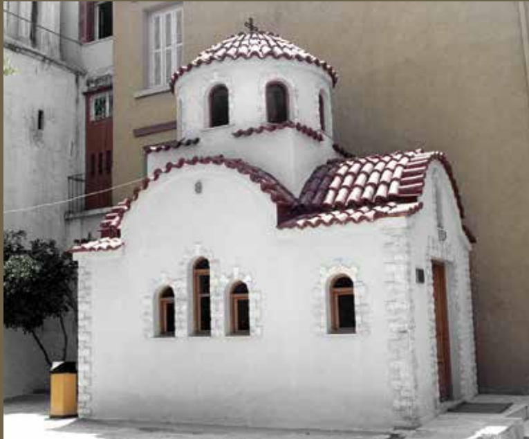
Βυζαντινή με τρούλο εξ' ολοκλήρου από σκυρόδεμα χωρίς να έχει ούτε ένα τούβλο ούτε κομμάτι ξύλου στην σκεπή
