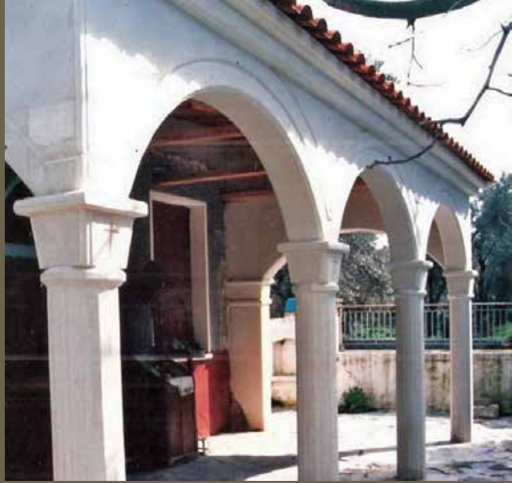
Εκκλησία στην Ευρειακή (νάρθηκας από εμφανές σκυρόδεμα)
