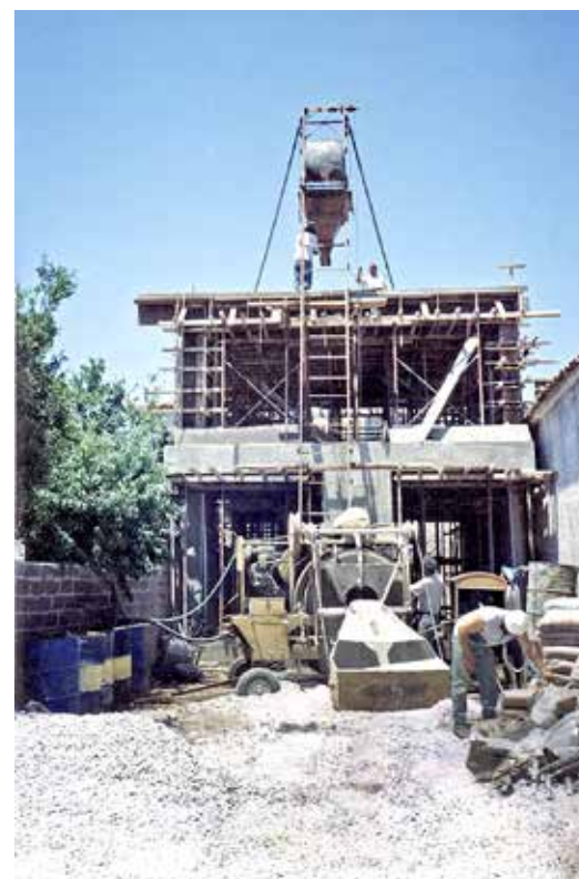
ΣΚΥΡΟΔΕΤΗΣΗ ΣΤΗΝ ΕΥΡΕΙΑΚΗ ΓΕΡΑΣ ΜΕ ΑΝΑΒΑΤΩΡΙΟ ΚΑΙ ΜΠΕΤΟΝΙΕΡΑ ΡΟΜΠΟΚΑ ΑΡΧΕΣ ΔΕΚΑΤΙΑΣ ΤΟΥ '80.
